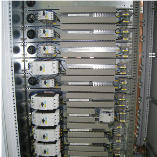
Verbraucherabgänge mit Leistungsschaltern / Consumer feedings with circuit breakers
